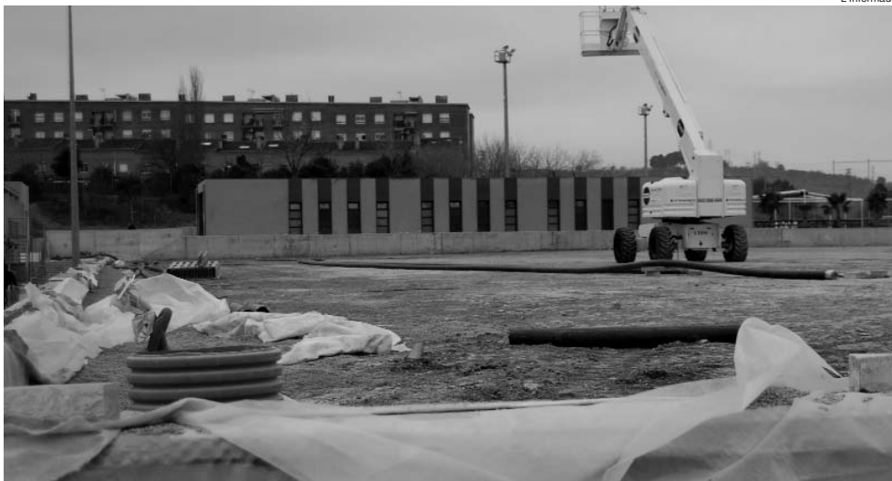
Nou camp. A Torrent de Llops avancen les obres de remodelació un cop enllestida la superfície del terreny de joc
